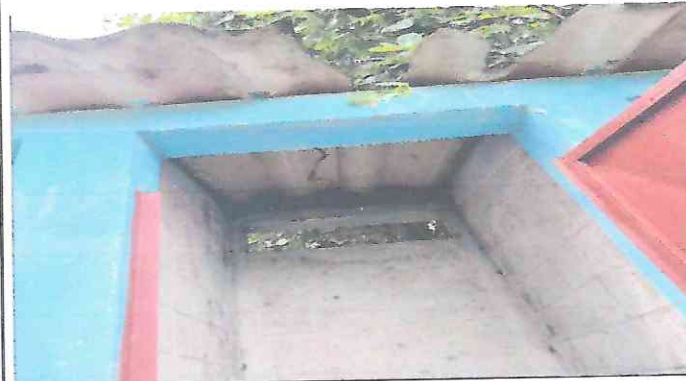
Foto 3: Cambio de lamina duralite a lamina traquetada
